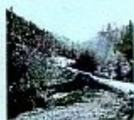
Le pont de Cabèil
