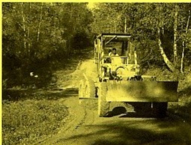
Les travaux à Rivièrevert sur la route des Abères.
