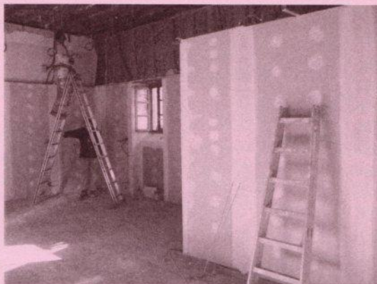
Les travaux à Rivèrenert.
